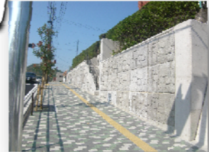
施工完成写真
